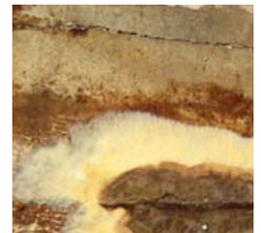
Les mérules dans les constructions, s'attaquent aux bois, notamment aux charpentes et boiseries des maisons humides et mal aérées. Dans la majorité des cas, la mэрule se niche souvent derrière un doublage, d'où sa détection tardive.
